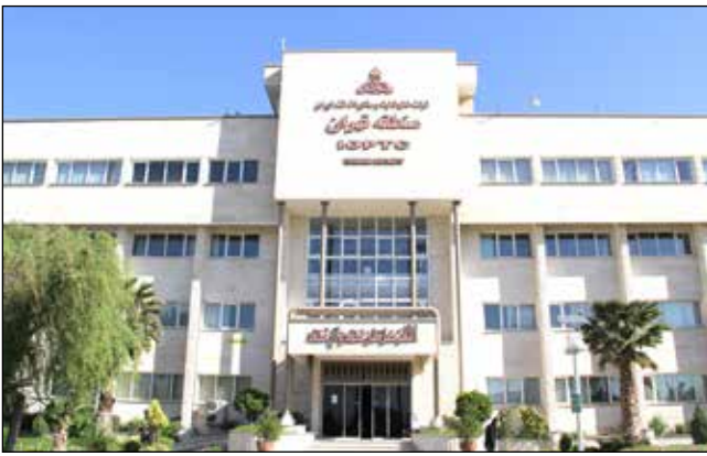
کسب رتبه نخست خط لوله منطقه تهران در بهینه سازی مصرف انرژی
