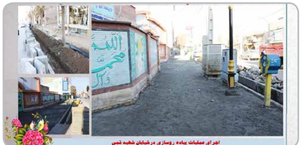
اجرای عملیات پیاده روسازی در خیابان شهید قمی
